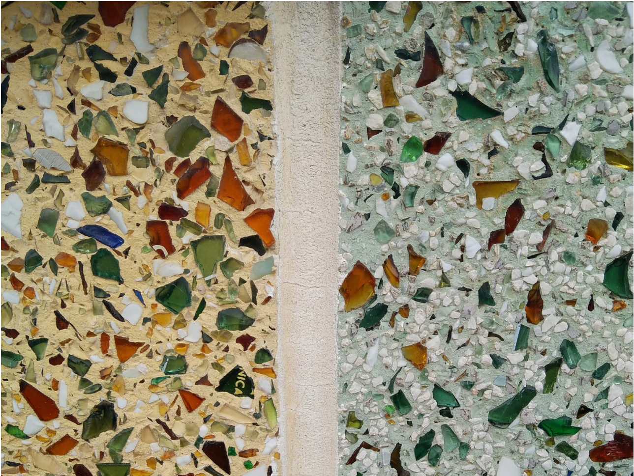
Figura 4. Diferentes agregados de vidro, pedra e junta de edifício na Rua D. João de Castro, Pinhal Novo.
