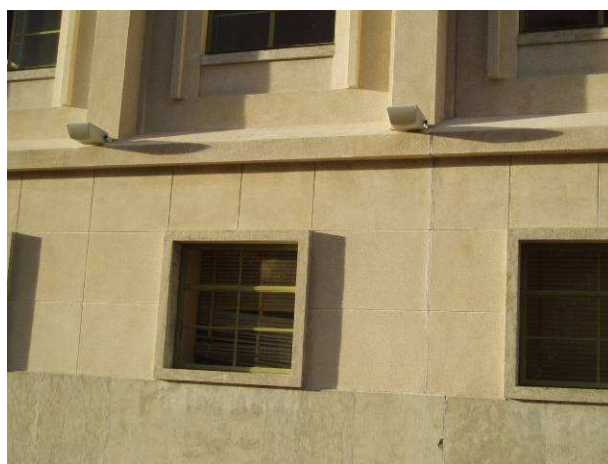
Fig. 28 – Pormenor de zona da Fachada Sul
