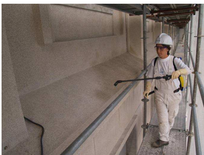
Fig. 20 – Colmatação de fissuras
