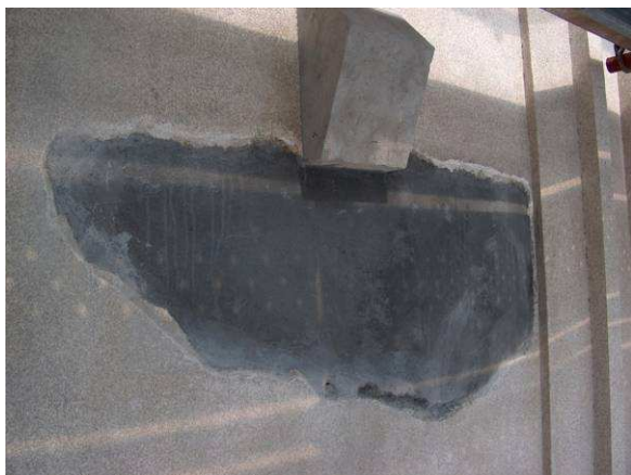
Fig. 18 – Tratamento de betão implicando remoção de revestimento
