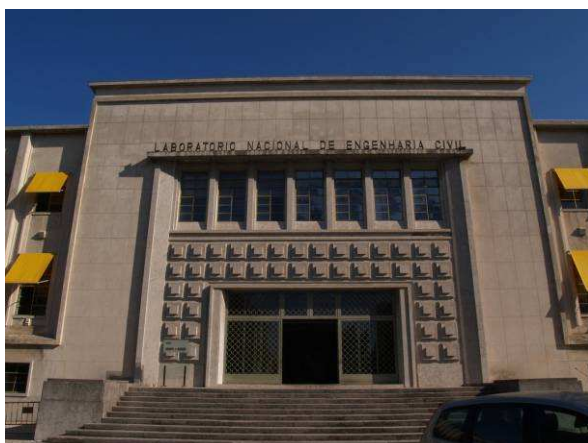
Fig. 1 – Aspecto da entrada da fachada do LNEC
