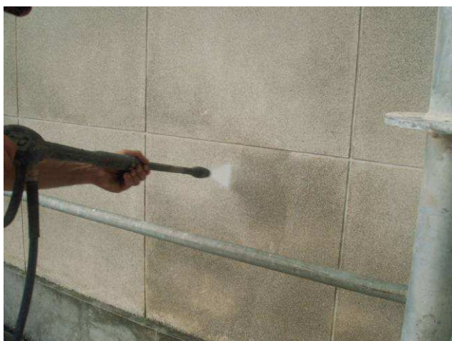
Fig. 16 – Limpeza com jacto de água a baixa pressão
