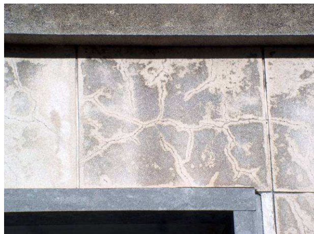
Fig. 11 – Fissuração
