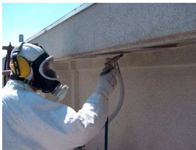
Fig. 17 – Limpeza com micro-abrasivo
