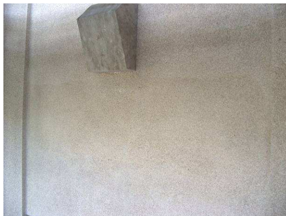
Fig. 19 – Marmorite de substituição
