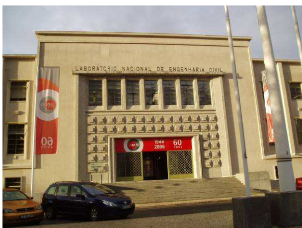
Fig. 27 – Aspecto final da entrada Principal (Fachada Sul)
