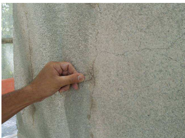
Fig. 20 – Colmatação de fissuras
