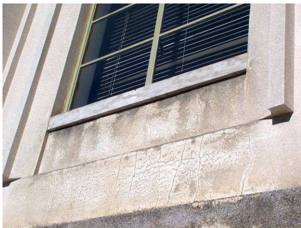
Fig. 10 – Micro-fissuração
