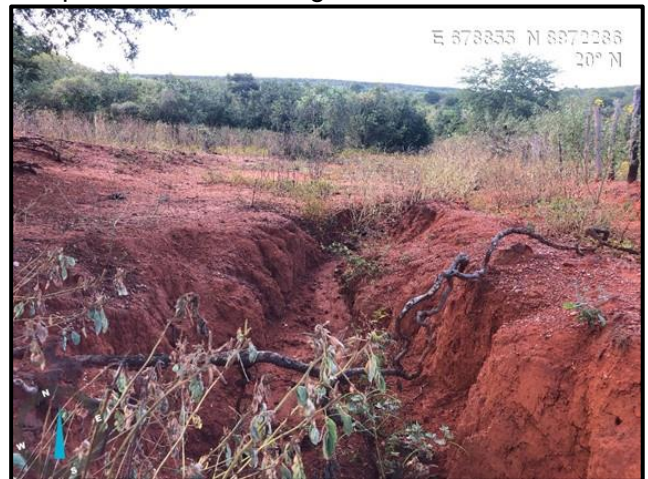
FOTO 6.1.4.4 – Feição erosiva em área próxima ao acesso mostrado na foto anterior em perfil de Argissolo. O fluxo turbulento das águas pluviais erodiu o local com a surgimento de um pequeno ravinamento.
