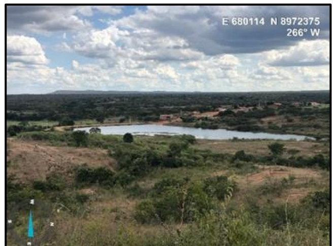
FOTO 6.1.7.10 – Detalhe do açude construído na localidade de Baixão do Moises.
