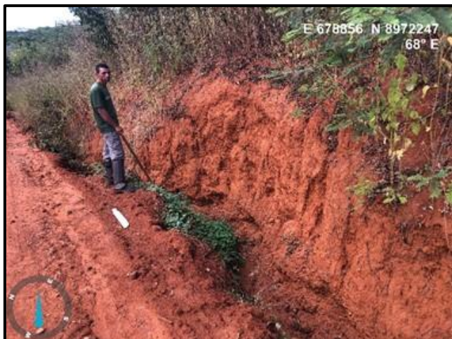
FOTO 6.1.3.7 – Corte em estrada na área de estudo, onde foi realizado descrição do perfil de Argissolo Vermelho Amarelo.
