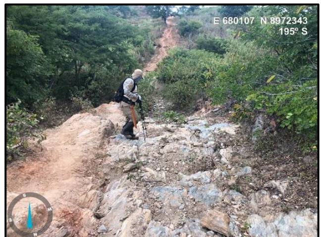
FOTO 6.1.4.6 – Estrada abandonada no limite leste da área de estudo. A declividade acentuada e o fluxo de água pluvial turbulento provocaram o aparecimento de diversas feições erosivas no local, sobretudo sulcos e ravinas de diversas dimensões.
