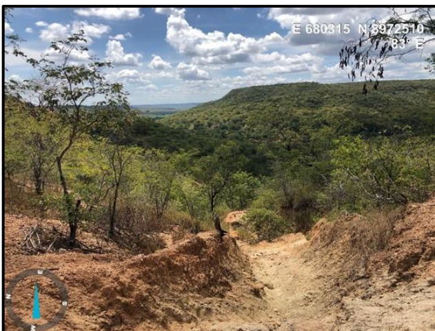
FOTO 6.1.4.5 – Estrada abandonada no limite leste da área de estudo. A declividade acentuada e o fluxo de água pluvial turbulento provocaram o aparecimento de diversas feições erosivas no local, sobretudo sulcos e ravinas de diversas dimensões.
