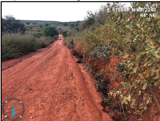
FOTO 6.1.4.3 – Sulcos na beira do acesso que atravessa a área de estudo originados pelo escoamento de água pluvial concentrado.
