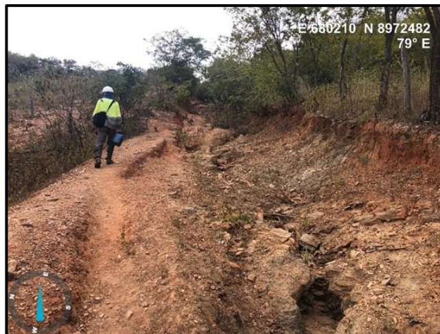
FOTO 6.1.4.8 – Sulcos e ravinas ao longo de um acesso próximo ao Baixão do Moises. As feições erosivas observadas são causadas pelo fluxo de água pluvial aliada a alta declividade do local.
