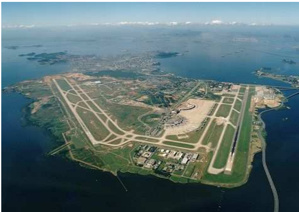
Figura 3.1 – Visão aérea do Aeroporto Internacional do Galeão, incluindo as duas pistas e os prédios (Birutanews, 2014)
