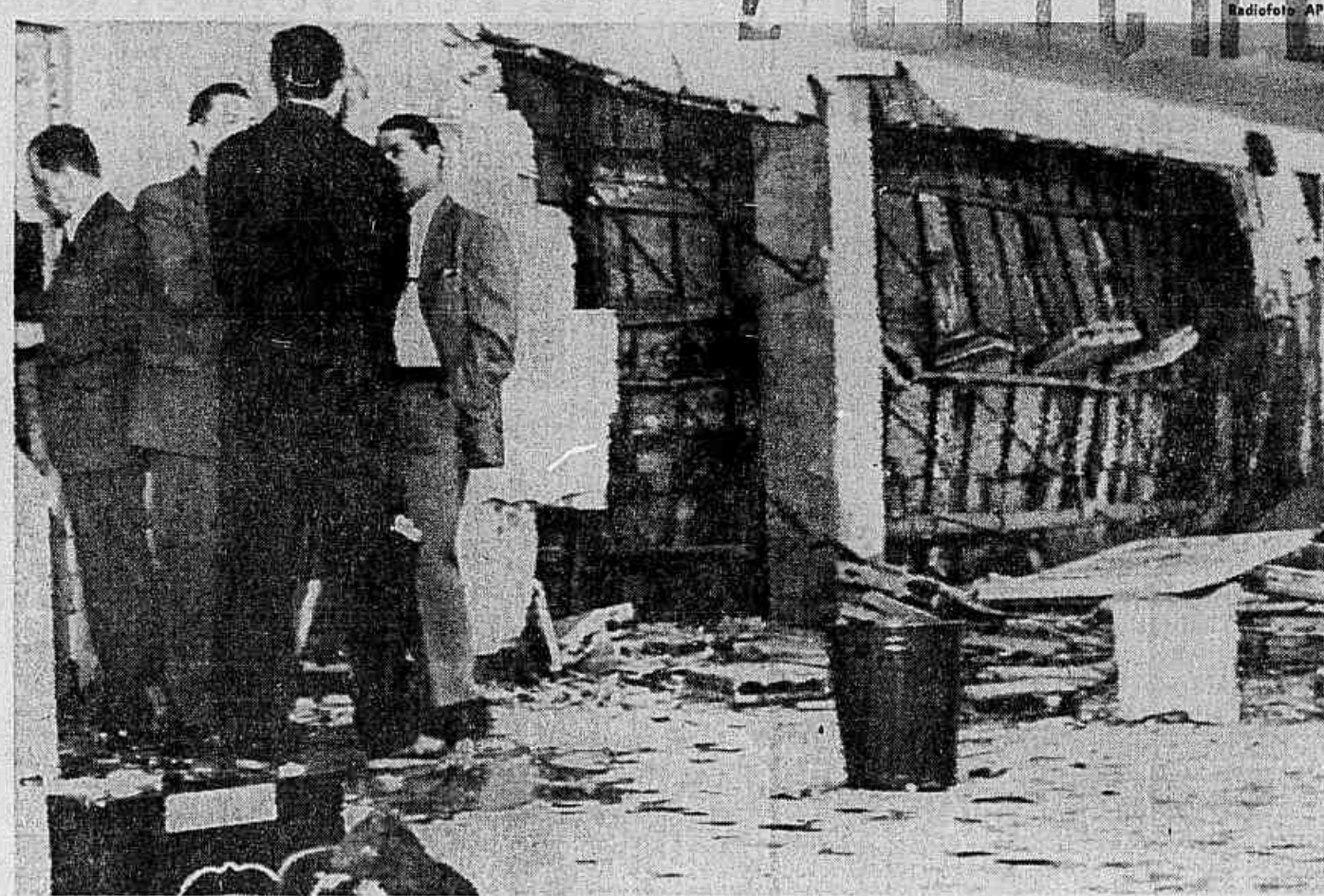
Cerca de 10 metros de paredes do setor da Força Aérea foram arrancados pela explosão
