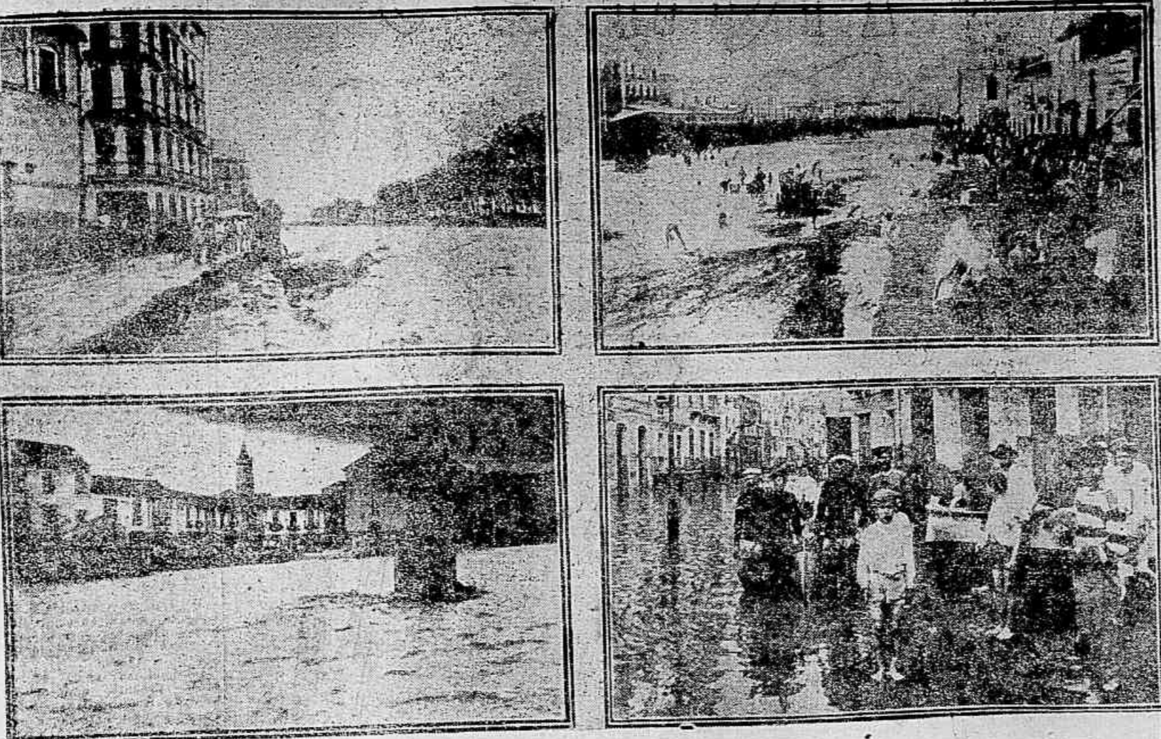
1 - Ruínas da ponte de S. Domingos, arrastada pela correnteza e o quebra-mar, durante a inundação. - 2 - Um trecho da rua da Porta, onde muitos moradores procuraram abrigo, fugindo à inundação. - 3 - Destruído da ponte Aurora, arrastada pela correnteza e a entrada da rua Marpole. - 4 - Marinheiros ao serviço de assistência às vítimas da inundação, na rua do Carmo.
